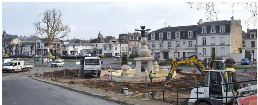
> Les travaux d'aménagement des abords de la fontaine ont commencé mi-janvier.
