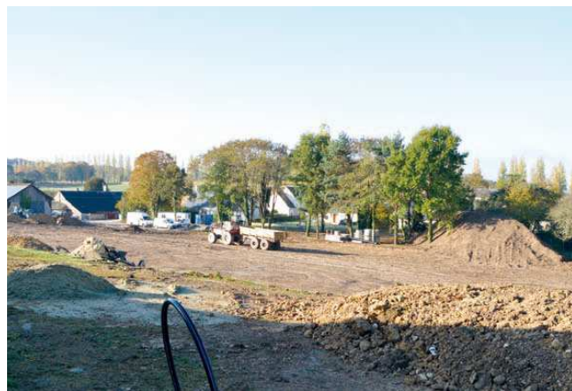
> Terrassement des 3 futures plateformes sportives.
